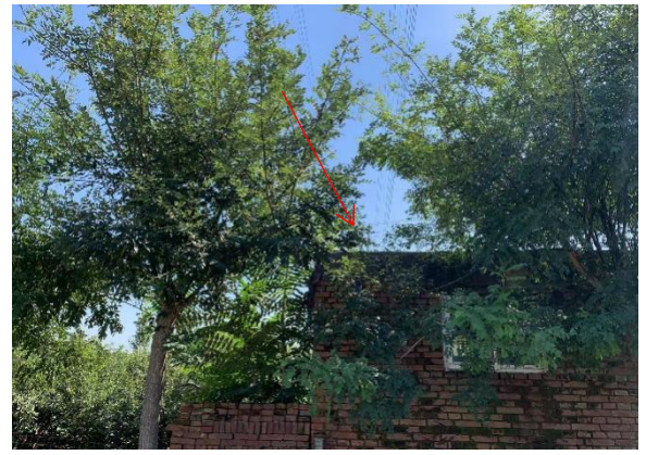
14. 220kV 孙畔线/孙庞线 53-54 号杆塔边导线西侧跨越，西白塔村西侧看护房
