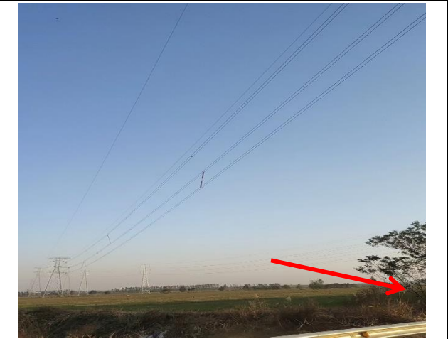
220kV堂庞线38号/220kV堂庞线39号单回路架空线路北侧衰减
