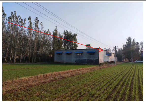
32. 220kV 孙畔线/孙庞线 62-63 号杆塔边导线 南侧 24m, 五岔路村西北侧民房
