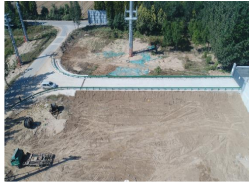
进站道路硬化
