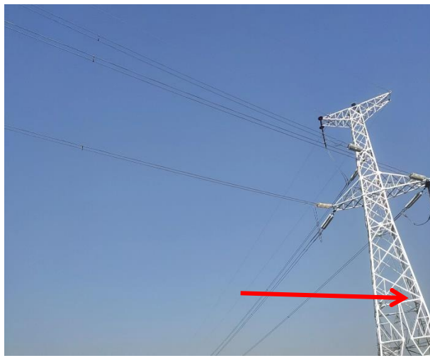
220kV堂畔线22号/220kV堂畔线23号单回架空线路北侧衰减
