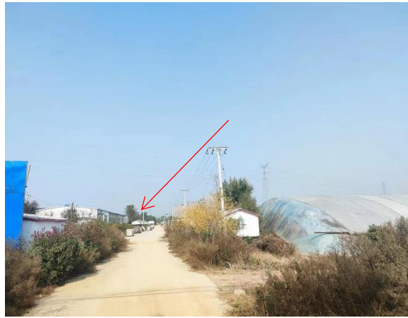
25. 220kV 孙畔线 103-104 号边导线跨越，山东润涛生态农业有限公司
