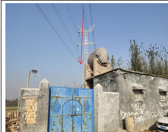
11. 220kV 孙畔线/孙庞线 59-60 号杆塔边导线跨越, 五岔路村西侧的看护房
