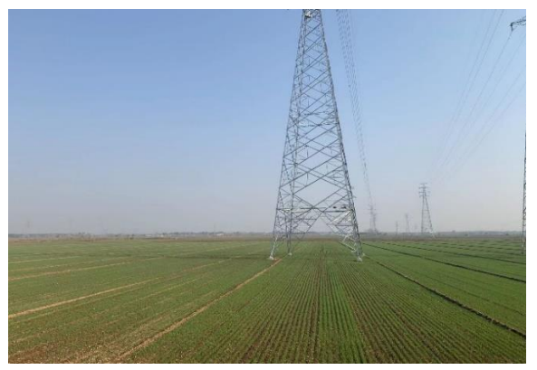
36. 跨越马颊河处 220kV 孙畔线 116#塔
