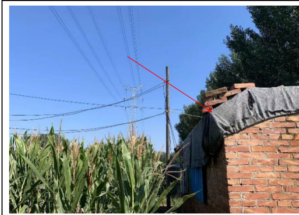
15. 220kV 孙畔线/孙庞线 49-50 号杆塔边导线南侧约 23m，杨寺地村北侧养殖场看护房
