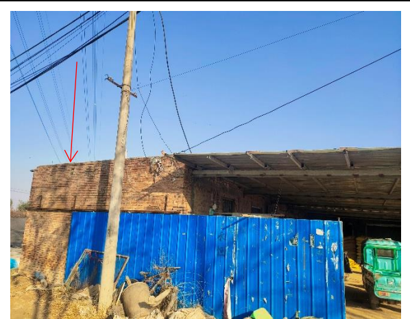
12. 220kV 孙畔线/孙庞线 55-56 号杆塔边导线跨越, 西白塔村北侧的看护房
