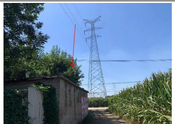
8. 220kV 孙畔线 81-82 号杆塔边导线跨越, 陈贯庄村南侧养殖场看护房
