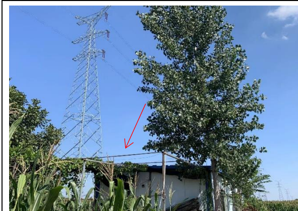
9. 220kV 孙畔线 78-79 号杆塔边导线南侧约 10m, 朵庄村北侧果园看护房
