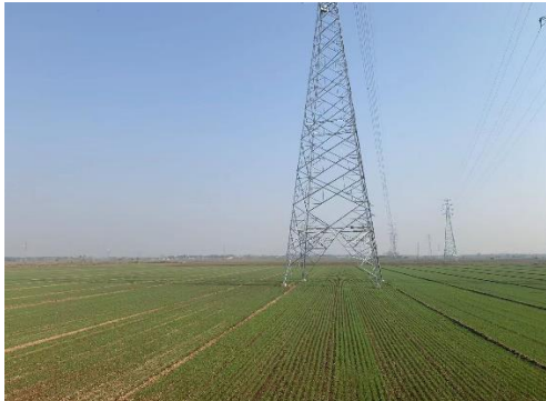
跨越马颊河孙畔线116#塔恢复
