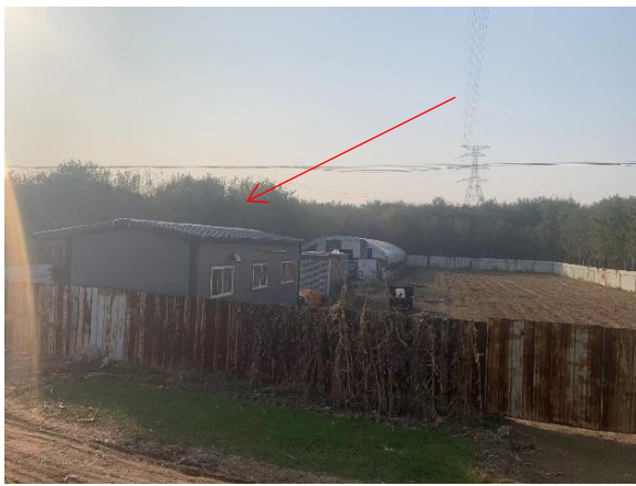
27. 220kV 孙畔线 88-89 号杆塔边导线南侧 8m，相里村西南侧大棚看护房
