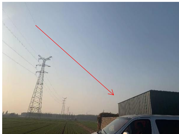
29. 220kV 孙畔线 69-70 号杆塔边导线北侧 38m，东开河头村西南侧养殖看护房
