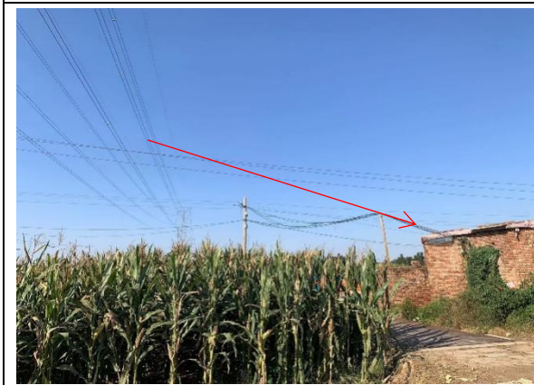
21. 220kV 孙畔线 12-13 号杆塔边导线东侧约 21m, 寨里村西侧废弃房屋
