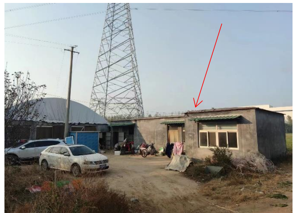
30. 220kV 孙畔线/孙庞线 64-65 号杆塔边导线南侧 15m，五岔路村东北侧大棚看护房
