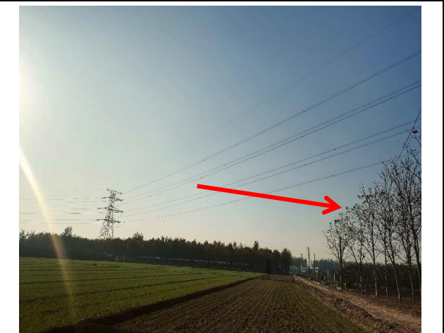
220kV孙庞线54号~55号/220kV孙畔线54号~55号双回架空线路北侧衰减
