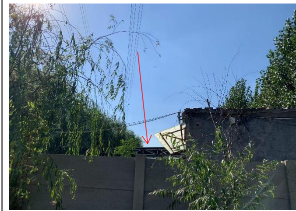
17. 220kV 孙畔线 42-43 号杆塔跨越，安庄村西南侧养殖场看护房
