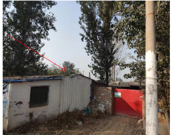
28. 220kV 孙畔线 75-76 号杆塔边导线跨越，范家村西南侧养殖看护房
