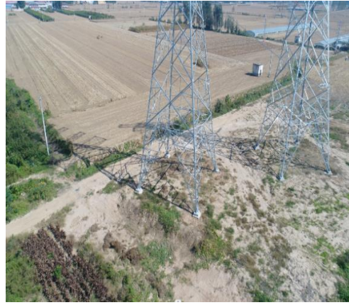
临时便道恢复
