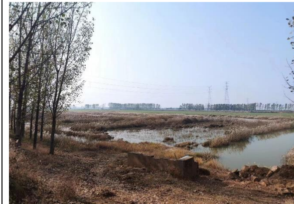
35. 跨越马颊河处
