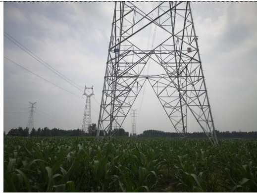
5. 220kV王亭线121号塔基下方恢复情况
