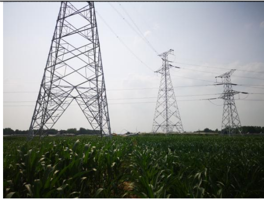
9、临时施工道路恢复情况
