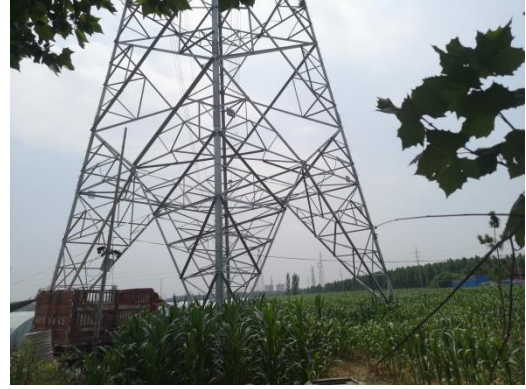
4. 220kV王亭线134号塔基下方恢复情况
