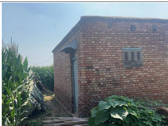
10.220kV 王亭线 108-109 号杆塔线下周楼村东 侧的看护房
