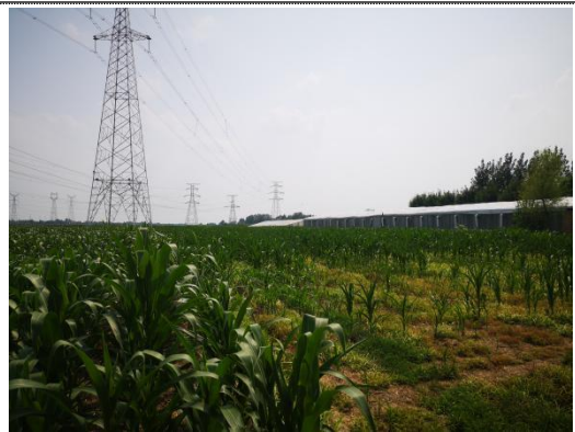
10、临时施工道路恢复情况
