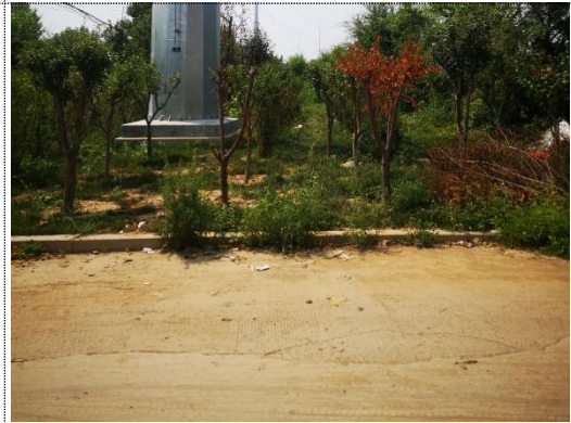
6. 牵张场恢复情况
