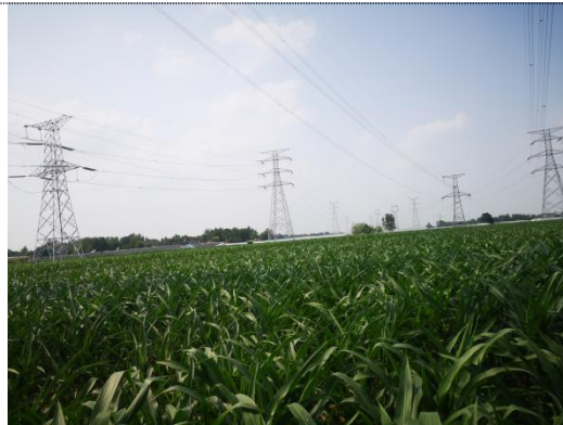
7. 牵张场恢复情况
