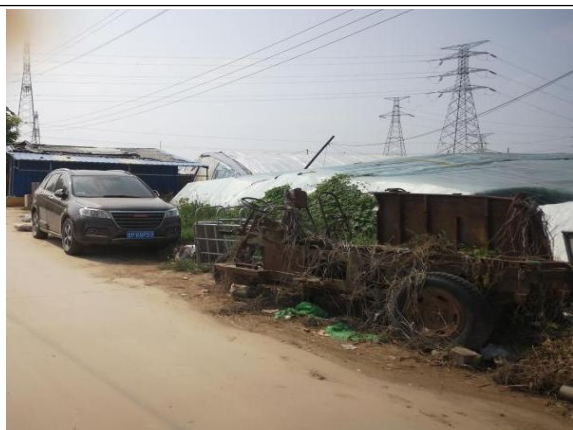
9.220kV 武亭 I 线 39-40 号杆塔边导线西侧 35m 周辛庄村东侧的看护房
