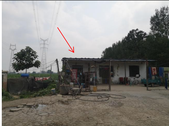
15.220kV 王亭线 119-120 杆塔边导线西侧 3m 尧舜村东侧的沿街房
