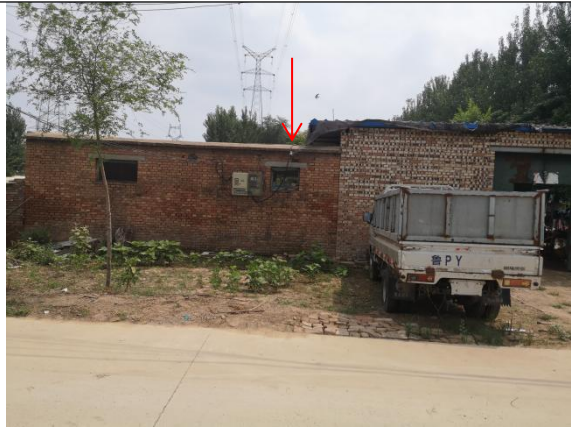
14.220kV 王亭线 116-118 杆塔线下礼院村东南侧的看护房
