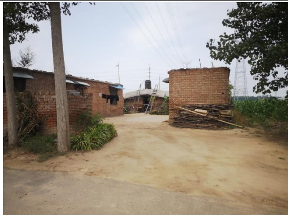
16.220kV 王亭线 121-122 杆塔边导线东侧 2m 盛屯村西侧的看护房
