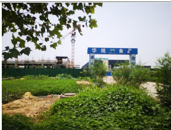
19.220kV 王亭线 132-133 杆塔边导线南侧 26m 华统食品在建厂房
