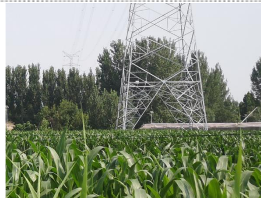
13、跨越徒骇河两岸塔基恢复情况
