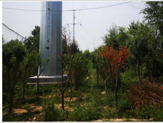
1. 220kV聊亭线151号塔基下方恢复情况
