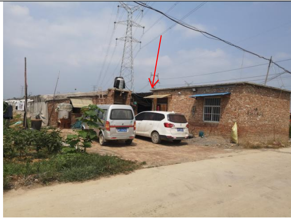
13.220kV 王亭线 114-115 杆塔边导线西侧 5m 肖屯村西侧的看护房
