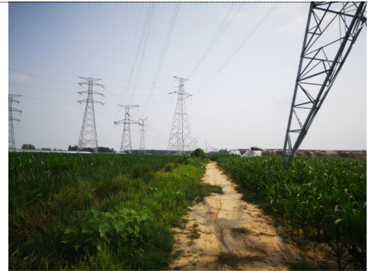
8. 牵张场恢复情况
