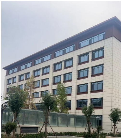
3. 围墙西侧输变电运维检修用房
