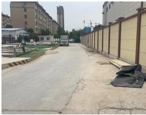
变电站临时堆场恢复情况
