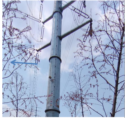
蒋干线19#~20#（新干线153#~154#、聊干线68#~69#）杆塔东侧衰减
