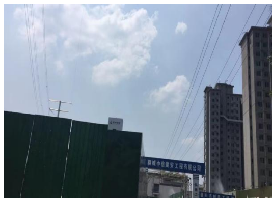
6. 边导线西侧建设东路南侧时代美境小区（在建）
