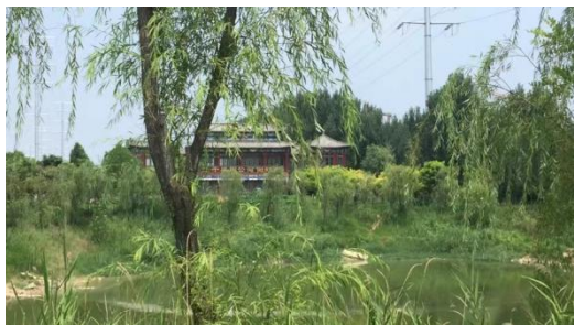
13.边导线东侧周公河北侧的位山二干渠管理所
