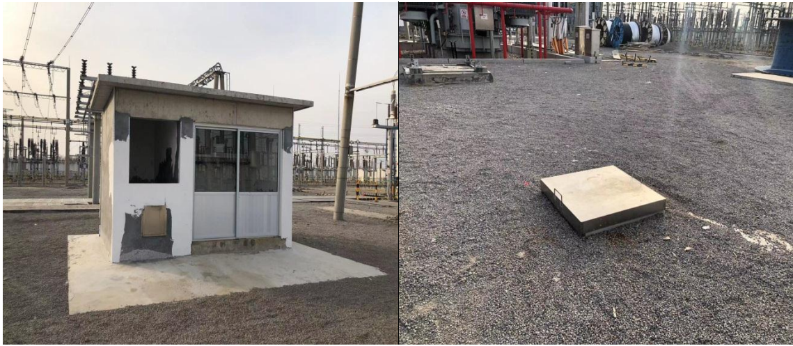
(4) 消防棚与事故油池
