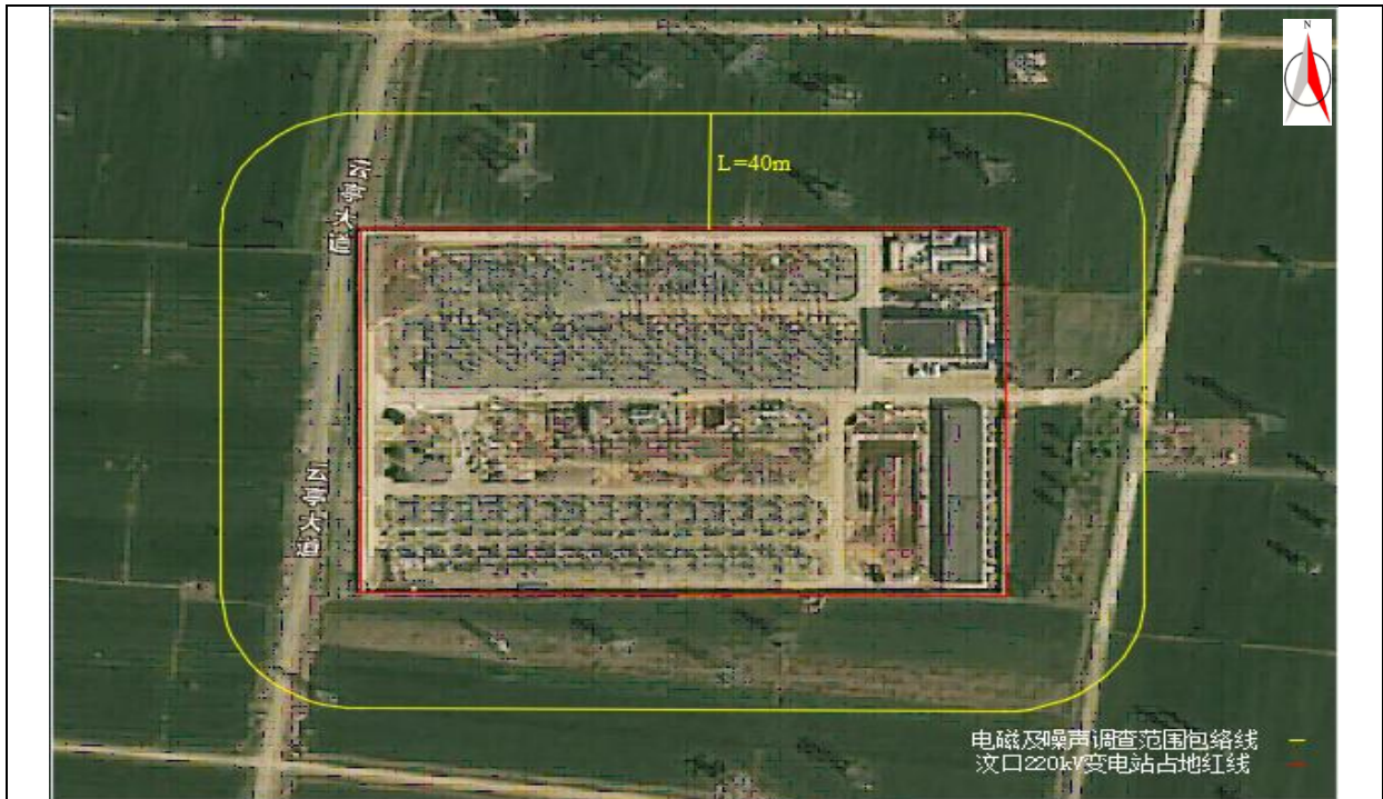
图 4-1-2 汶口变电站周边情况 (1:2500)
