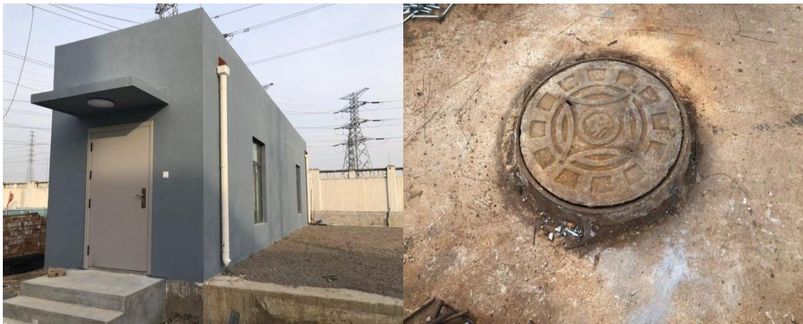
(5) 水泵房与化粪池
