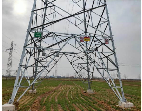
8.杆塔下方恢复情况
